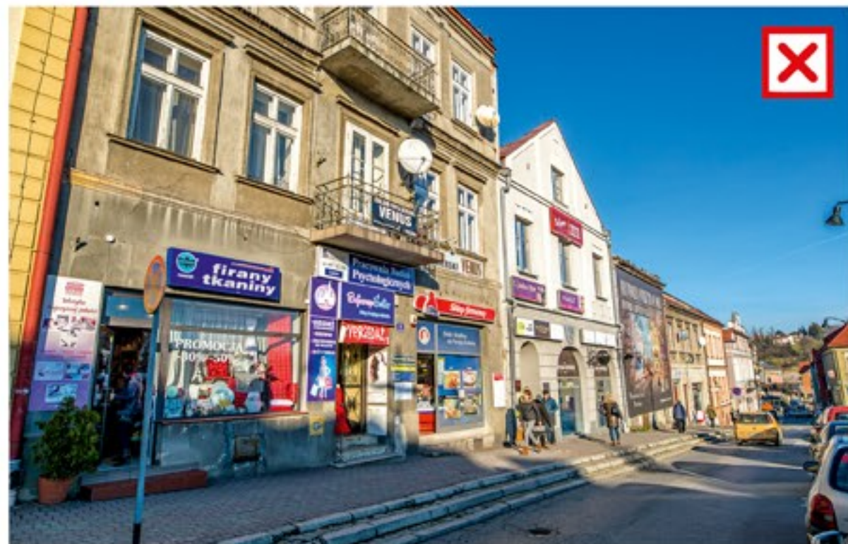
Kamienica ul. Rynek 11- 2017 rok Stan istniejący kamienicy przy Rynku 11 to estetyczny chaos spowodowany głównie spiętrzonymi, nachodzącymi na siebie nośnikami reklamy przestrzennej. Dominują kasetony reklamowe w różnych kolorach, co potęguje poczucie nieładu. Zauważalne są zbędne powielenia treści reklamowych, które paradoksalnie poprzez dublowanie przekazu zamiast eksponować treść, wprowadzają zamęt, w którym ich przekaz zostaje zagubiony. Nad wejściem głównym do kamienicy widoczny baner reklamowy. Nośnik słabej jakości pozbawiony walorów estetycznych
